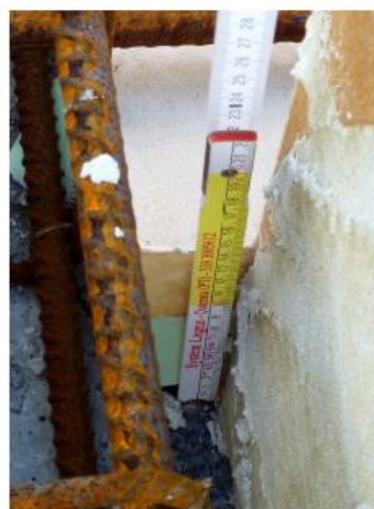
6. Verifica dello spessore dei pannelli coibenti in xps (sp.=6 cm) e poliuretano (sp.=5 cm)
