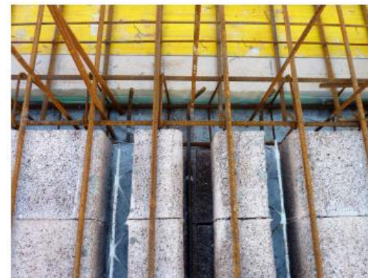
3. Stato avanzamento lavori per la realizzazione dei terrazzi: all'introdasso della soletta sono stati posizionati pannelli coibenti in xps e poliuretano.
