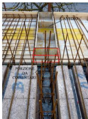
5. Dettaglio della cassera e della coibentazione in corrispondenza del cavetto sul fronte tergale dell'edificio
