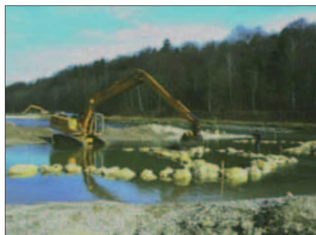
Lavori di riqualificazione nei pressi di Monaco di Baviera.
