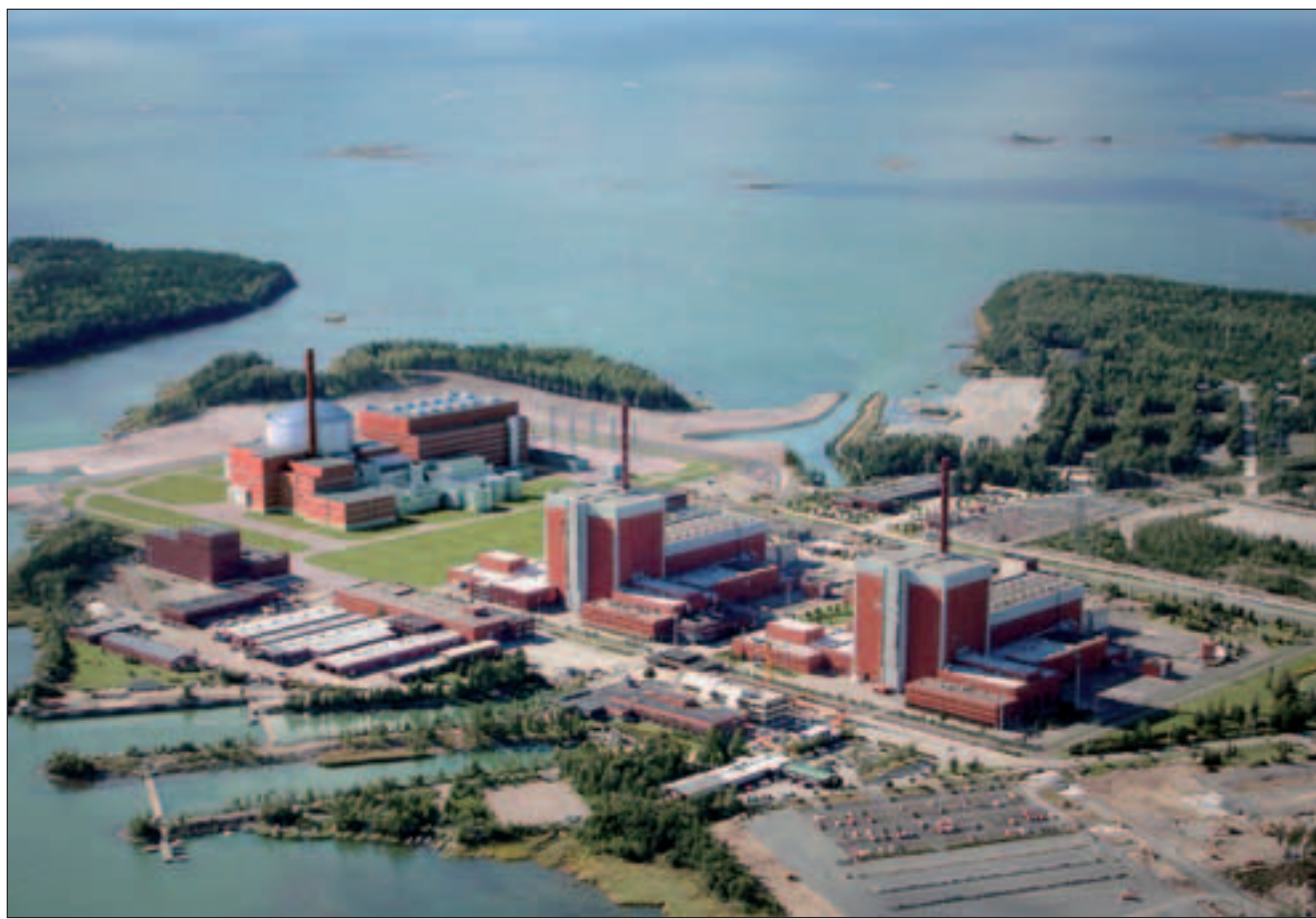
La centrale nucleare finlandese di Olkiluoto, reattore nucleare europeo ad acqua pressurizzata, meglio noto con la sigla EPR. Sulla destra i due vecchi reattori già esistenti, sulla sinistra la simulazione in computer grafica del costruendo reattore. L'ultima data prevista per il completamento è il 2012
